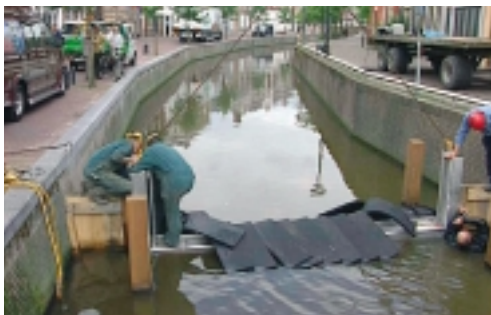
Separering av rent och förorenat vatten, Leeuwarden
