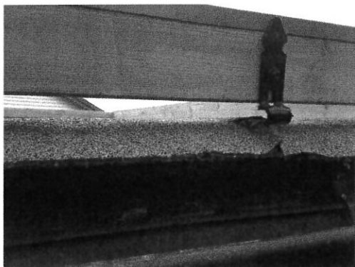
Foto 4b. Høy klaring mellom takdekke og avslutningslist er en utfordring. Bruk av filt, nett eller småstein for å hindre at substrat havner i takrenna må vurderes av den enkelte produsent, og meldes til inn.
