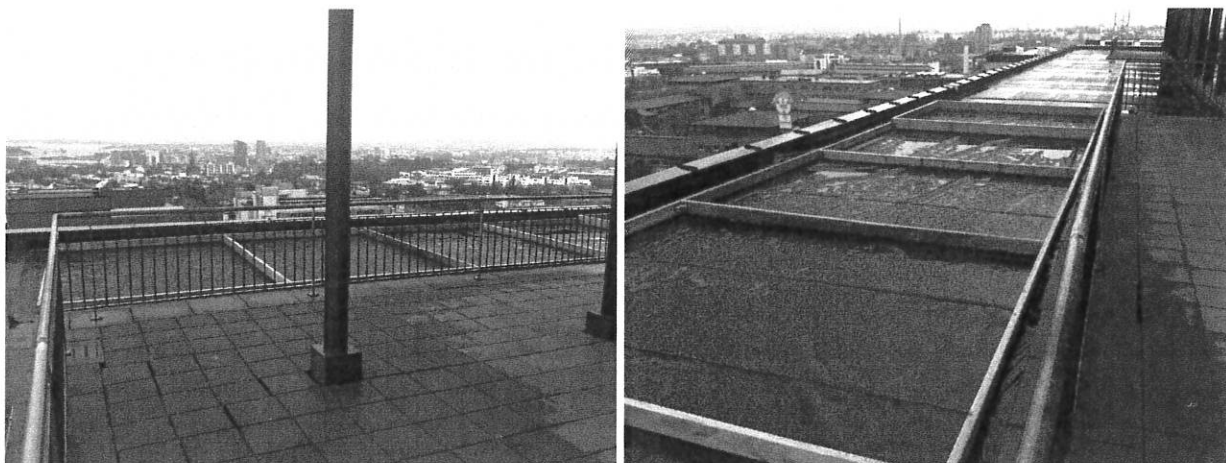
Foto 1: Flott utsikt over Oslofjorden. 5 ruten med rotsperre er anlagt på taket i 11. etg. (foto: Einar Flaa) Semi-intensive tak i foto 2 er plassert rundt hjørnet på bildet til høyre. Montering av vegetasjon er etterlengtet, fordi vinden kaster om på rotmembranen!
