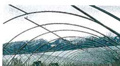
Elite tunnel frå Arctic Tunnel med nedsenka rør i toppen. Dette gir ein sterk konstruksjon der tau og plast kan strammast betre. Foto: Aksel Døving.
